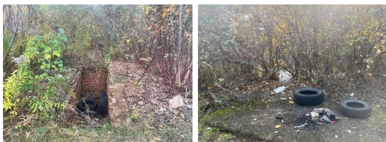
33 pav. Gretimo sklypo buvusioje garažų teritorijos „terasoje“ gausu įvairaus pobūdžio statybinių atliekų likučių. Visos teritorijos plote suformuotas apie 2–4 metrų storio dirbtinio grunto (smėlio, žvyro ir statybinių atliekų mišinio) sluoksnis.
