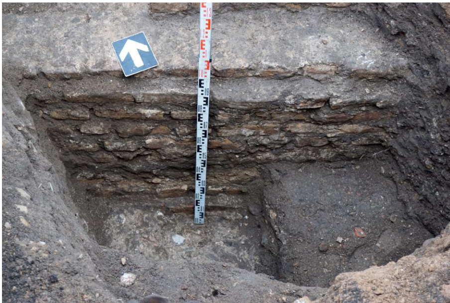
36. Perkasa 3, joje atkastas buv. varpinės pamatas iš P. Matuoklė stovi ant iš kalkių skiedinio ir akmenų formuoto pagrindo ("banketės") varpinės pamatui. Vaizdas iš P.
