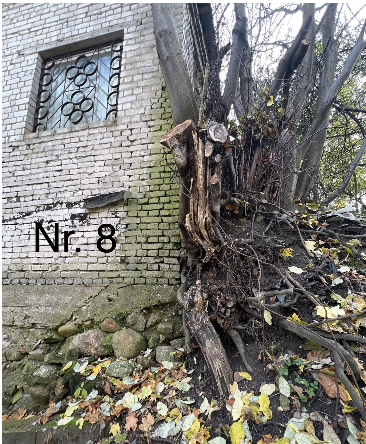
Paprastoji ieva (nr. 8 plane) - didžioji šaknų dalis auga iš po pamato, dalis šaknyno nuslinkusi ir laikosi tik atsirėmusi į sieną. Prasti kodominantiniai kamieno suaugimai. Siūloma šalinti.
