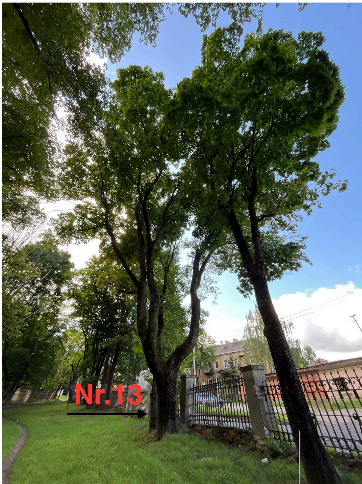
Paprastasis klevas (Nr. 13 plane) - kodominantinių kamienų suaugimo vietoje formuojasi drevė, galimas puvinys. Augavietė apribota iš pietų ir vakarų pusės. Rekomenduojamas kodominantinių kamienų suaugimų būklės monitoringas kas šešis mėnesius dėl galimų pakitimų ateityje, bei lajos priežiūros genėjimas.
