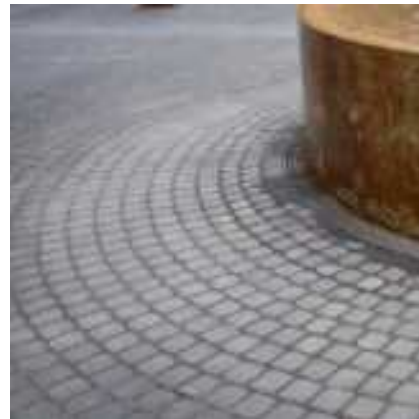
HS03 - Betoninės trinkelės, 160x160mm
