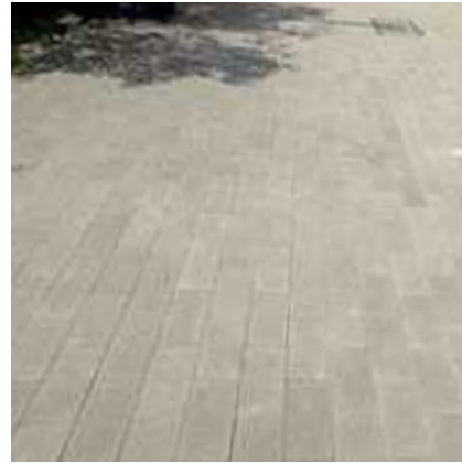
HS02 - Betoninės trinkelės 160x240mm
