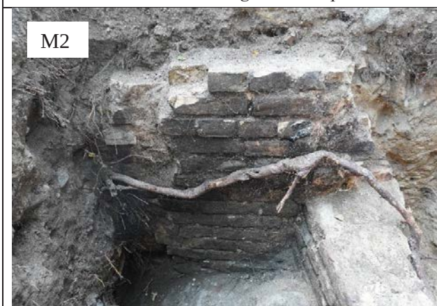
F.18.3. Buvusio švieslangio sienelė iš R pusės
