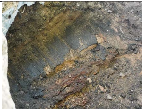
F.7.4. Pastato vidinėje patalpoje buvusių sudegusių medinių grindų, paklotų ant molinės aslos, fragmentas
