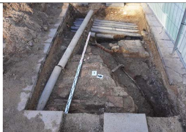
F.1.2. Pamato ir rūšio skliauto viršutinė dalis iš R pusės.
