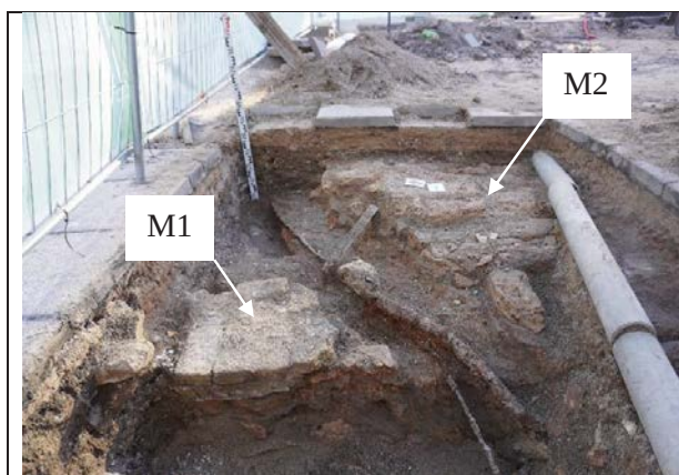
F.1.1. Pamato ir rūšio skliauto viršutinė dalis iš V pusės.
