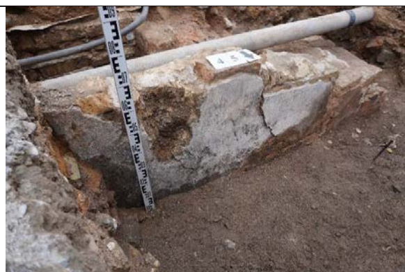
F.45.5. Sienelės tinkuotos ir remontuotos.
