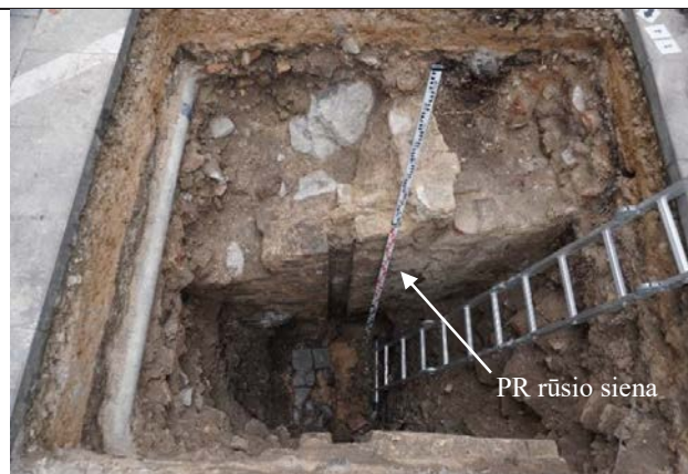
F.14.2. PR rūsio siena ir buvusių durų – staktos vieta bei skersinės vidinės sienos fragmentas iš PR pusės iš ŠV pusės
