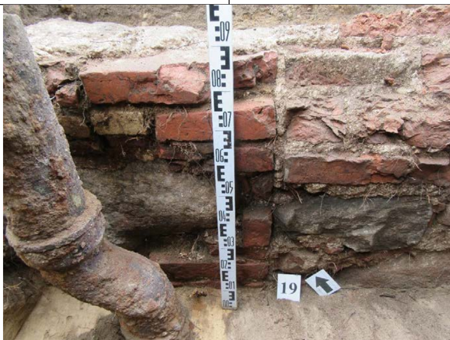
F.19.3. Dviejų pastatų, Vokiečių g. 12 ir 14, pamatų dalys, sandūros vieta iš PR pusės.
