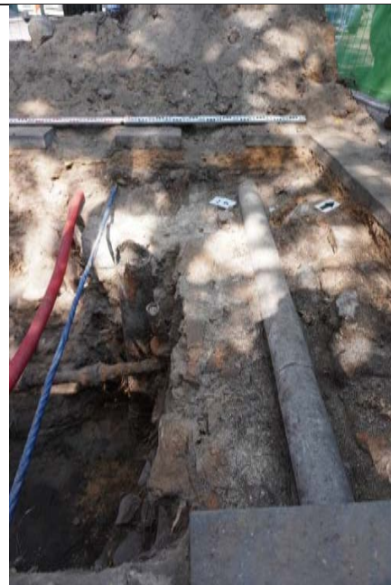
F.26.2. Akmenų mūro pamatų dalys su plytų mūro fragmentais viršutinėje dalyje bei akmenų grindinio liekana iš PR pusės
