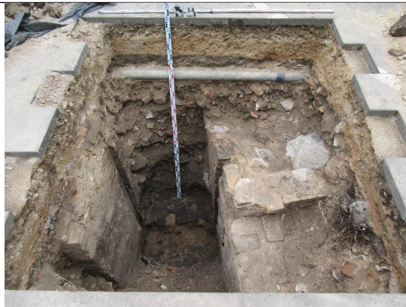
30. Šurfo Nr. 14 bendras vaizdas iš PV pusės.
