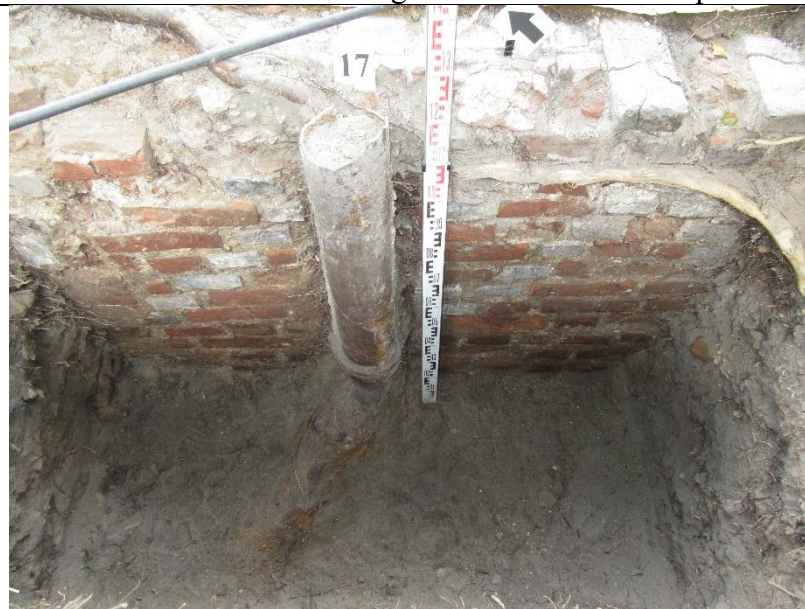
40. Šurfe Nr. 17 atidengto mūro išorės vaizdas iš PV pusės.
