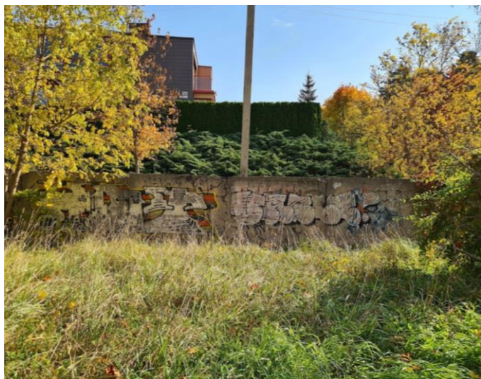
Pav. 2. Gelžbetoninė tvora.
