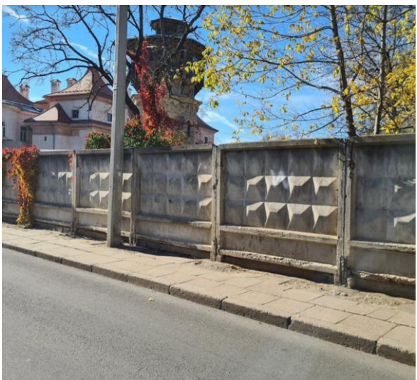
Pav. 3. Gelžbetoninė tvora.
