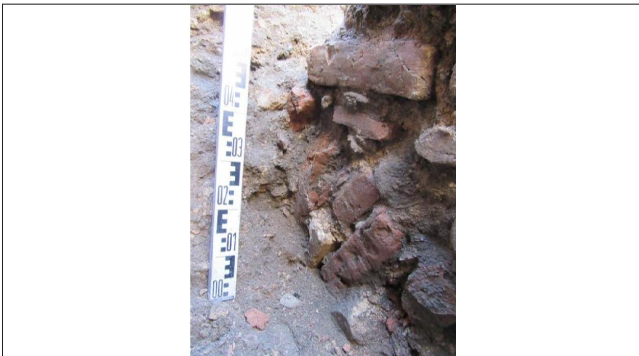
F.37.6. Pamato M2 PR pusėje – arkinės konstrukcijos fragmentas.
