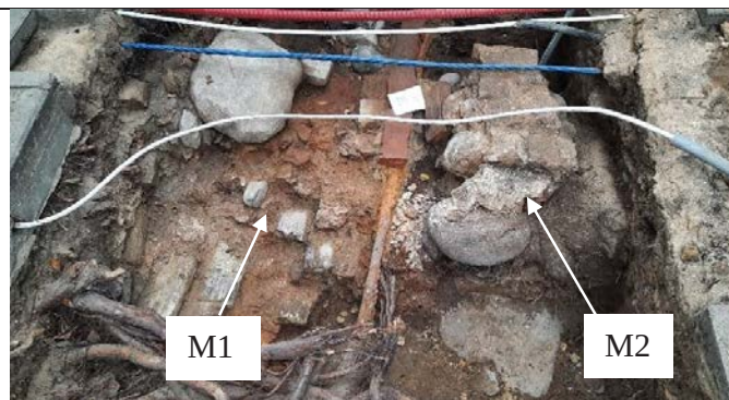
F.29.1. Stipriai suardytų pamatų paviršiai iš PV pusės.
