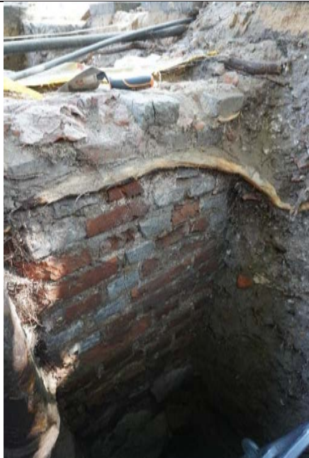
F.17.3. Kapitalinės plytų mūro sienos dalis su pamatu iš ŠV pusės
