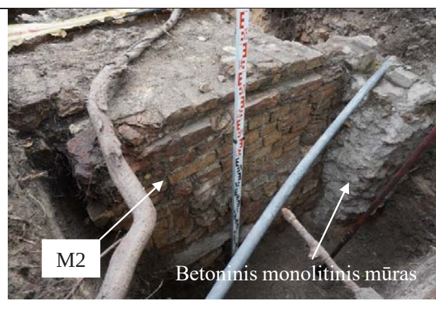
F.15.2. Kapitalinių sienų pamatai iš PV pusės – primūryta, remonuota dalis.
