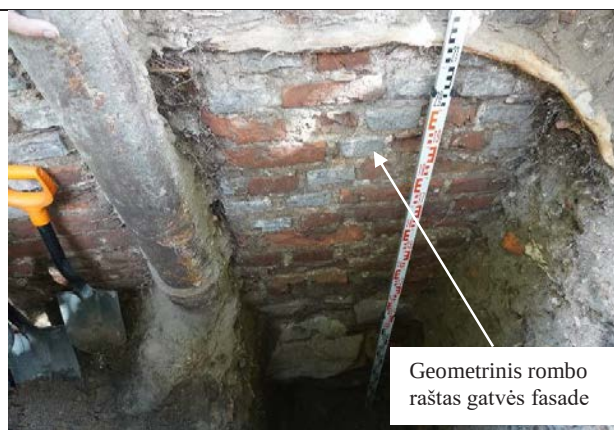
F.17.2. Kapitalinės plytų mūro sienos dalis su pamatu iš gatvės (PV) pusės. Gatvės išklotinės linija.
