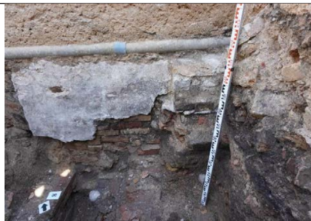
F.8.6. Tinkuota laiptinės siena su buv. pakopų žymėmis.
