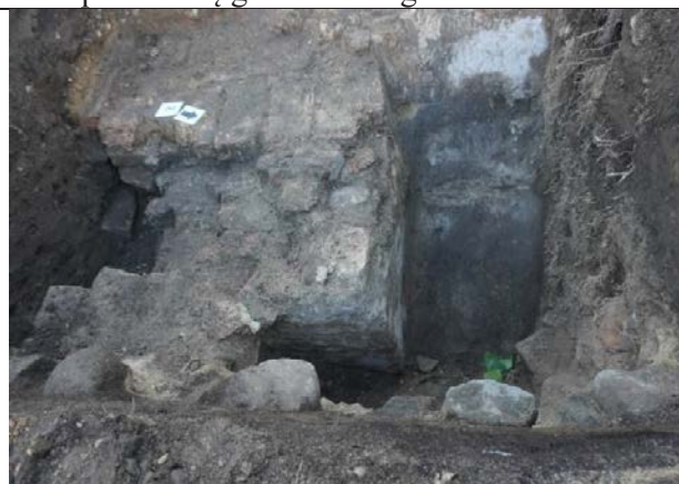
F.2.2. Pamato kampinė dalis su švieslangio vieta iš pastato vidinės pusės - iš ŠR.
