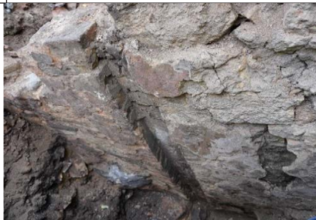
F.14.3. ŠV rūsio siena ir staktos vieta bei skersinės sienos fragmentas
