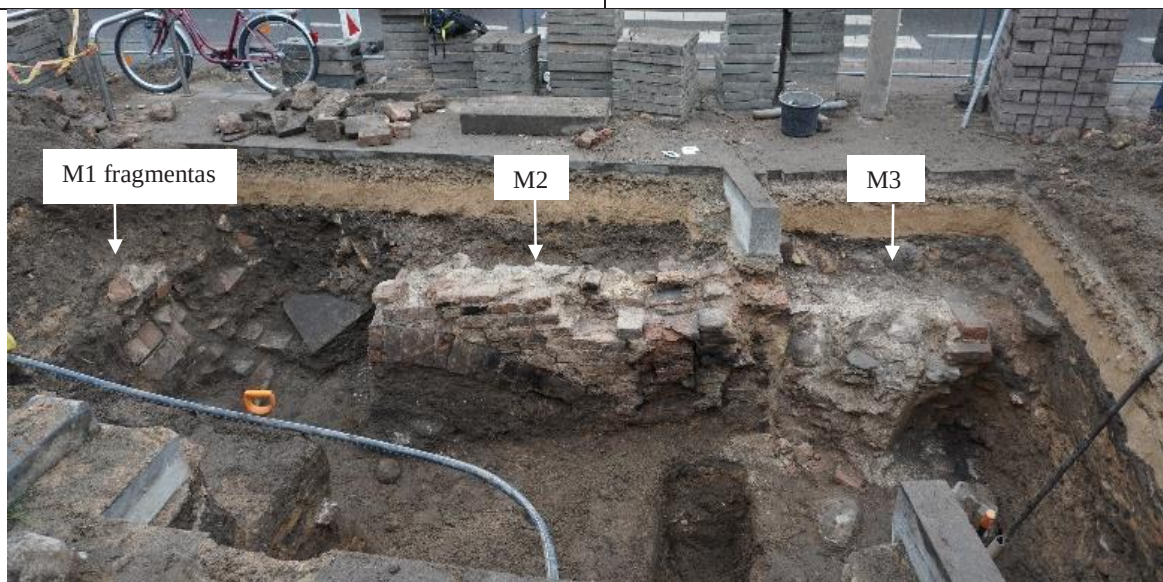
F.P2.7. Rūsio siena ir praėjimo vieta su arkine sąrama (M2) bei kapitalinio pamato dalis (M3) iš PV pusės
