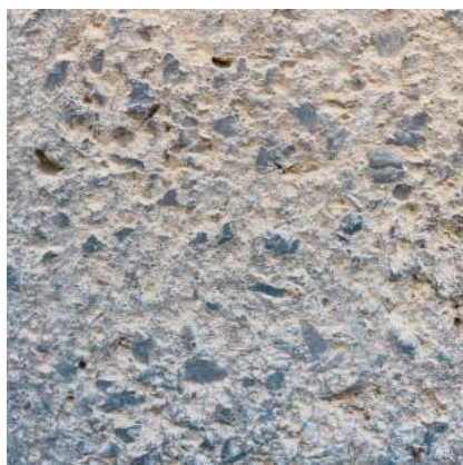
Šiurkštintas betonas laikančioms sienoms
