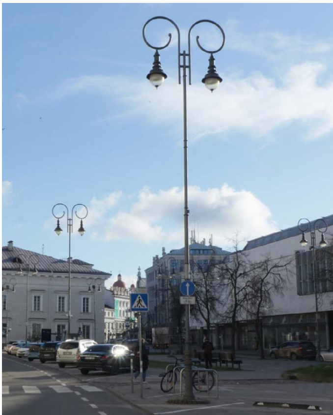
Esamas bendras foninis gatvės apšvietimas
