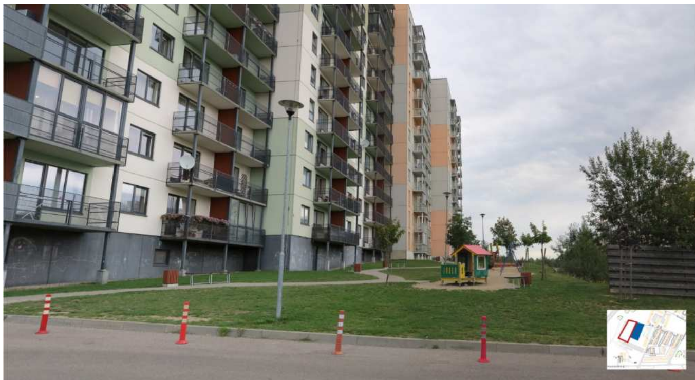
Perkūnkiemio g. 53-55 – gyvenamasis daugiaaukštis namas su kiemu (vaikų žaidimų aikštelė, nauji želdiniai, vingiuojantis takas, šviestuvai, suoleliai ir šiukšlinės).
