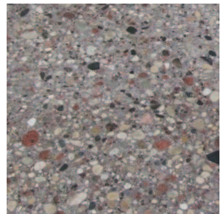
Vietoje šlifotas betonas laiptams ir rampai
