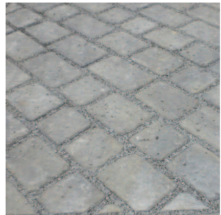
Vandeniui laidži betoninių trinkelų danga / 100x200mm
