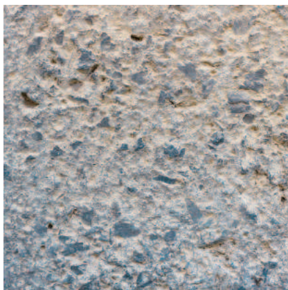
Šiurkštintas betonas laikančioms sienoms
